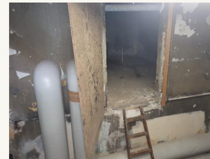
Indgang til kulsiloer
