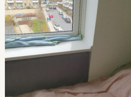
Træk ved vindue
