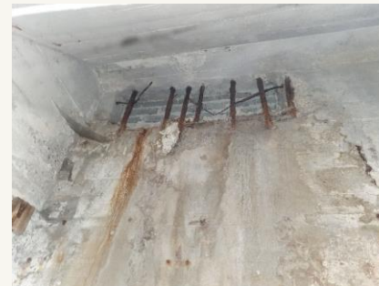
Tilmuring af oprindeligt murhul, med blotlagte armeringsjern.
