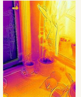
Facade og gulv ved altandør.
