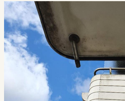
Udspyrrør fra altanbund.
