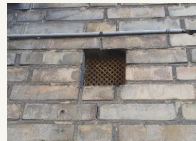
Ventilationsåbning med rist.
