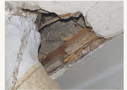
Skade ved rørgennemføring mod kælder
