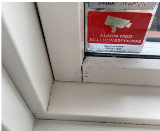
Foto 10.5. Fugtplamager i hjørnet af rammen (i soveværelse). Åretegninger i træ er blevet synlige efter opfugtning.
