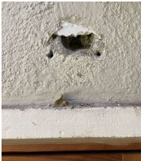
Foto 9.13. Hur i facade ved depotrum, muligvis efter afmonteret ventilationsrist.
