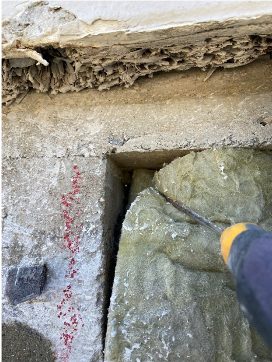
Foto 9.41. Facade Samling betonsøjle og betonbjælke. Vederlaget synes intakt. Der kan registreres en skråtliggende revne umiddelbart under vederlaget.
