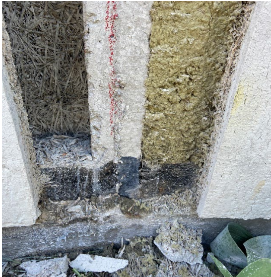
Foto 9.33. Sokkeldetalje ved gavl. Betonsøjlen står på fundament og betonremme støder op til søjlen. Smøremembranen er påført front af betonrem samt synlig overside og yderside af fundament.
