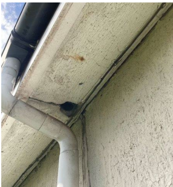
Foto 7.13. Hul efter gennemføring af oprindeligt nedløb.
