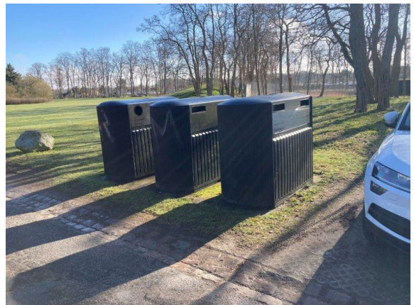
Foto 22.6. Affaldssorterings ø. Manglende tilgængelighed
