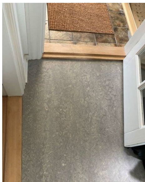
Foto 12.8. Klinker i entre, linoleum i gang.
