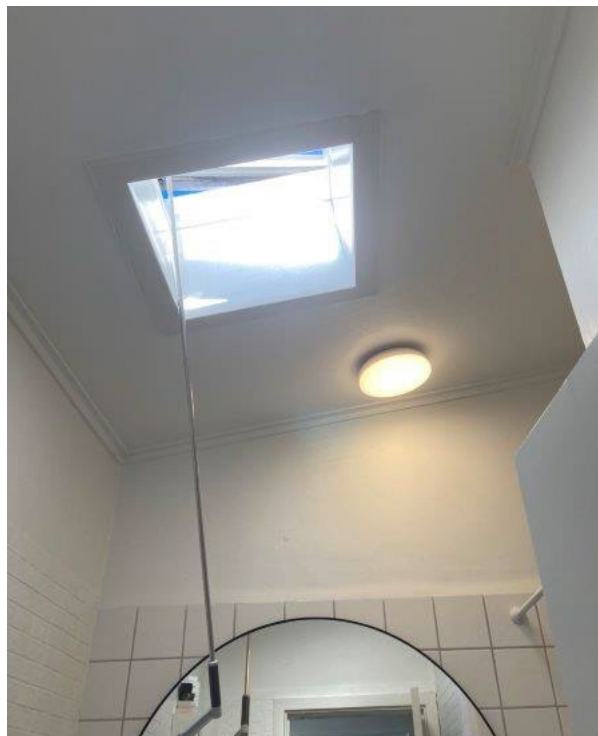
Foto 13.8. Originalt badeværelse med fliser på nederste vægstykke og malet overstykket, samt pudset loft.
