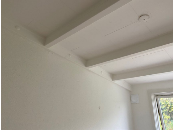
Foto 7.27. Indvendig afstivende trækonstruktion (åse) under betondæk
