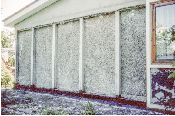
Foto 9.3. Tidligere foto af ukendt dato. Gavlmuren med blottede søjler. Over søjler er placeret en betonbjælke og gavltrekanten er opmuret
