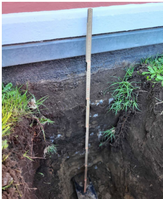
Foto 8.1. 0,95 m til underside af fundament, målt fra terræn.
