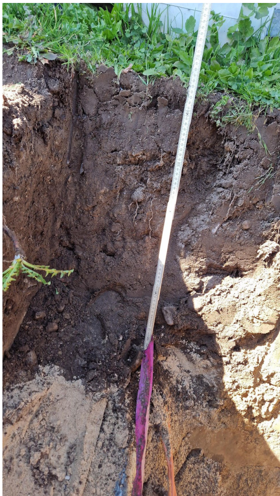
Foto 15.15. Udgravning til fjernvarmerør omkring Kjærparken 75. Rørene er nedgravet i ca 65 cm dybde.
