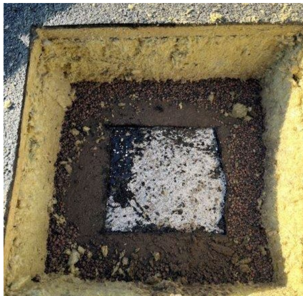
Foto 7.16. Oplukning af efterisolering
