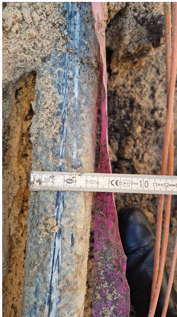
Foto 15.16. Fjernvarmerørene har en tykkelse på ca. 55 mm inkl. isolering og isoleringskappe.
