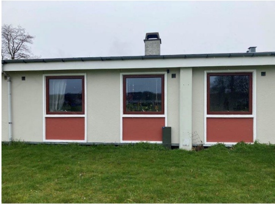
Foto 10.3. Rækkehuse med røde vinduer og brystninger. Vinduer afvander på omramning.
