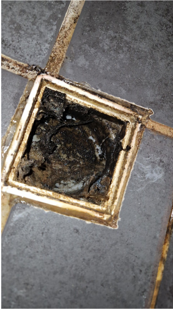
Foto 16.5. Gulv afløb i bruseniche med vandlås
