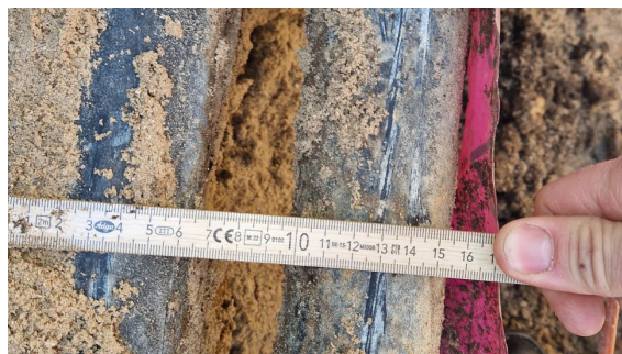
Foto 15.18. Fjernvarmerørene ligger separat ved siden af hinanden.
