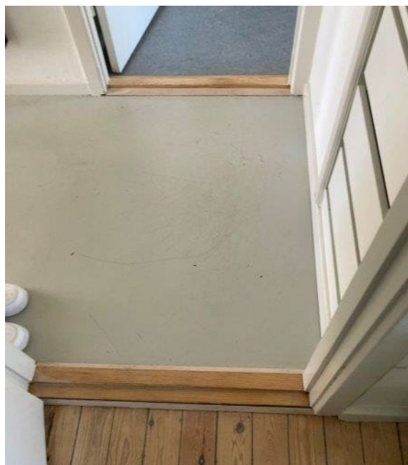
Foto 12.6. Linoleum i køkken, malet beton i gang og fyrretræ i værelse.
