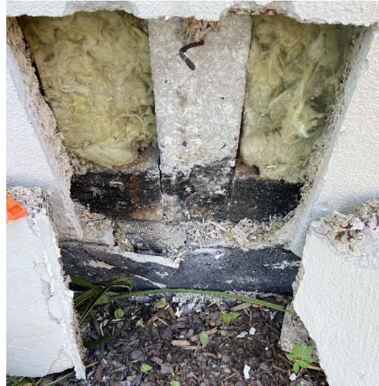
Foto 9.34. Sokkeldetalje ved gavl. Smøremembranen er påført front af betonrem samt synlig overside og yderside af fundament.
