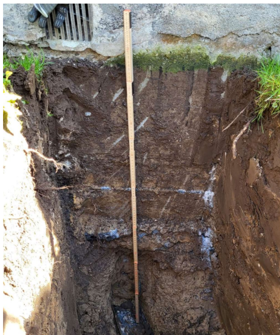
Foto 8.3. 1,10 meter til underside af fundament målt fra terræn.
