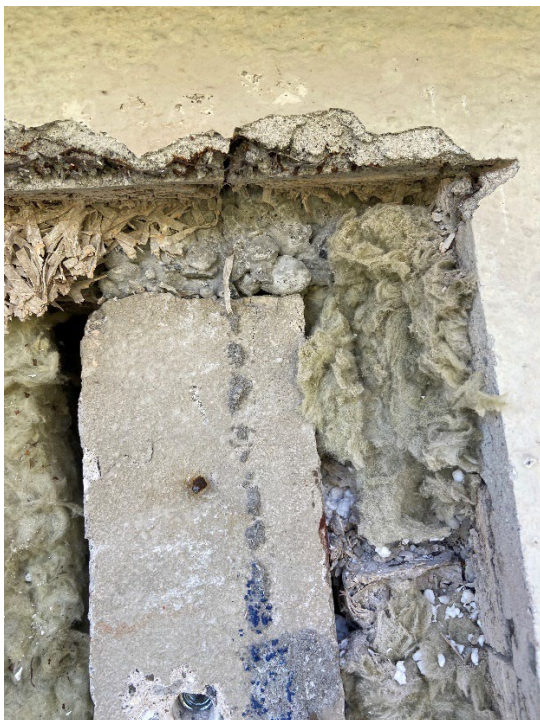
Foto 9.43. Facade. Samling betonsøjle og betonbjælke. Vederlaget synes intakt.
