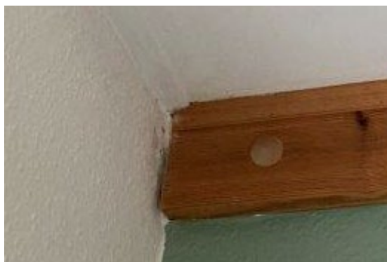
Foto 9.23. Skimmeldannelse på væg ved loft og åse.
