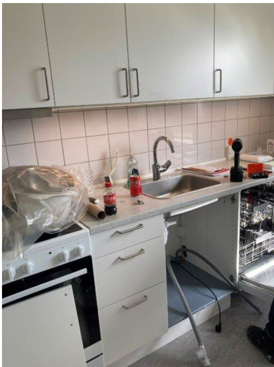
Foto 14.1. Flytteejlighed var ved at blive klargjort til ny beboer. Istandsættelse pågår under registreringen. Laminatlåger, fliser på væg, linoleumsgulv.
