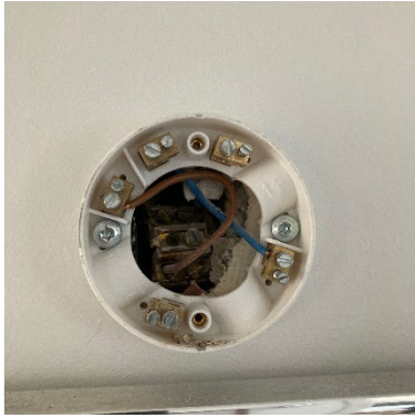
Foto 19.1.17 Eksempel på lampeudtag med PVC-ledere.
