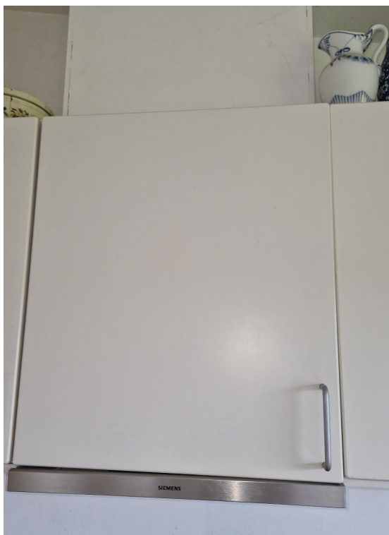
Foto 18.3. Emhætte med afkast til det fri over tag
