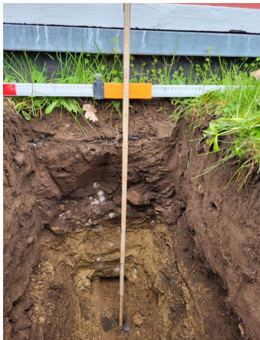
Foto 8.2. 0,95 m til underside af fundament målt fra terræn.
