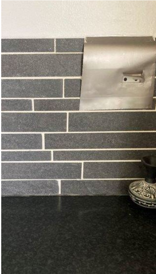
Foto 14.5. Nyere renoveret køkken, fliser på væg med malet overstykke og granitbordplade.
