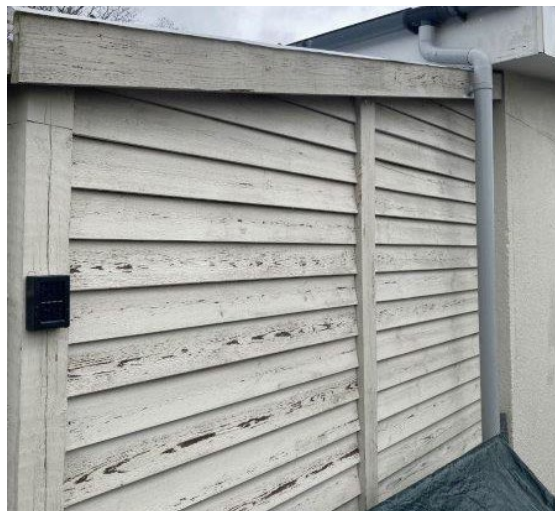
Foto 9.18. Revnedannelser i samlingerne mellem træbetonpladerne.
