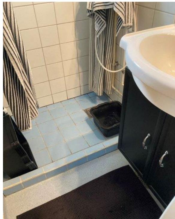
Foto 13.2. Ombygget badeværelse, med varierende materialesammensætning der vidner om flere partielle renoveringer. Fliser og vinyl.
