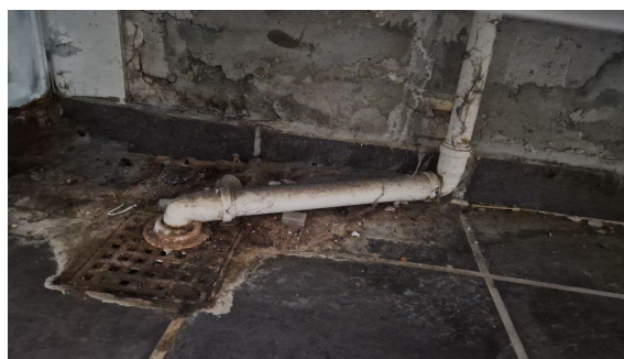
Foto 16.4. Gulvafløb under håndvask
