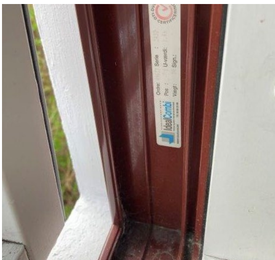
Foto 10.7. Da vinduet er udskiftet er der monteret en ekstra indfatning for tilpasning.
