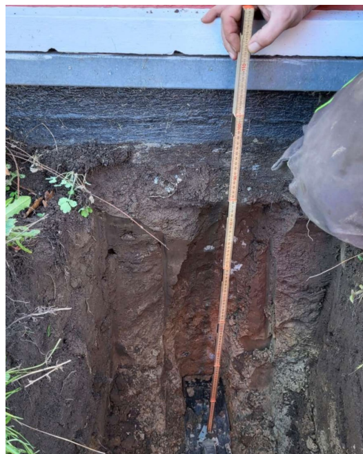
Foto 8.4. 0,9 meter til underside af fundament målt fra terræn.
