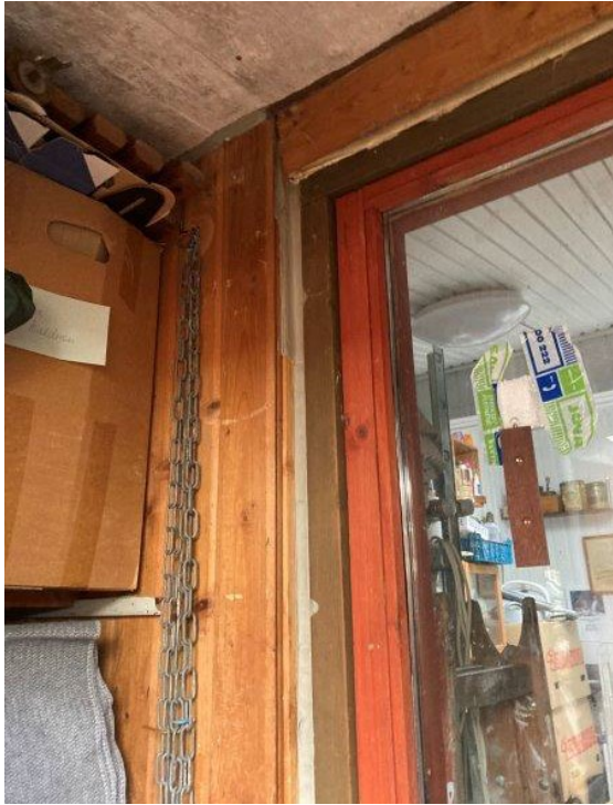
Foto 10.17. Ældre vindue mellem depotrum og skur.
