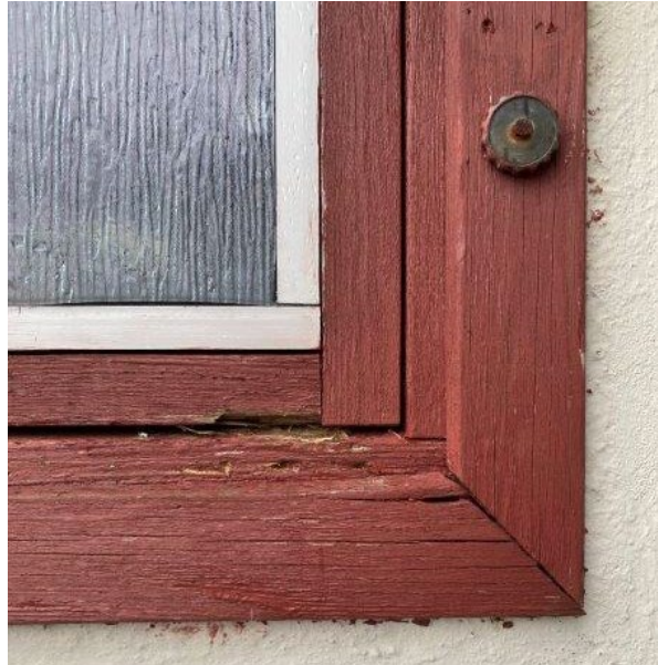
Foto 10.14. Ældre vindue i depot. Dette er ikke skiftet, da vinduet ikke er en del af de oprindelige vinduesplaceringer. Vinduet mangler malervedligehold og fremstår med synligt mørtet træværk.
