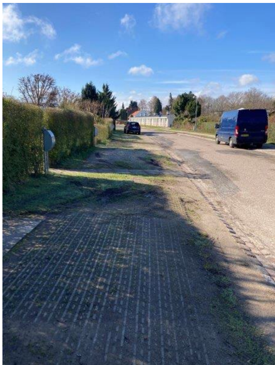
Foto 20.5. Græsarmering til parkering, græsstykke og flisebelægning fra havegang. Intet fortorv. Manglende tilgængelighed til boligerne.
