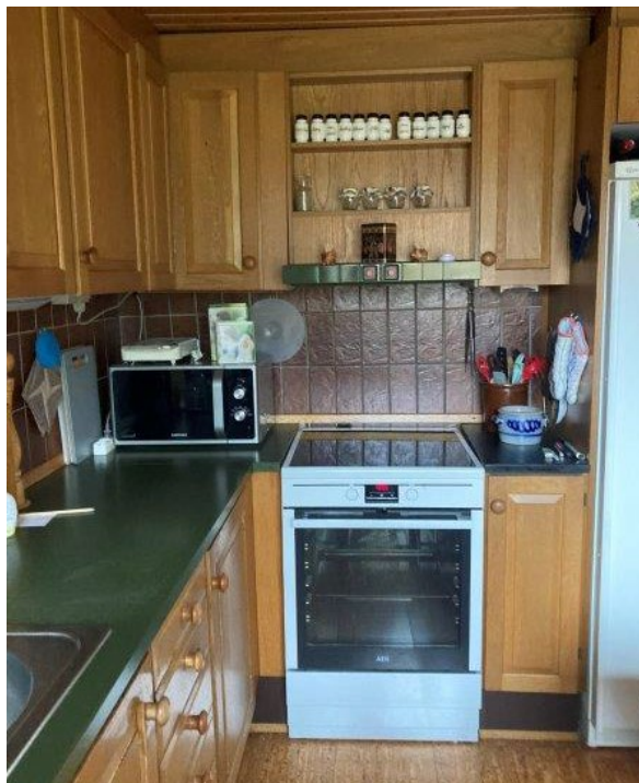
Foto 14.4. Ældre renoveret køkken, ca. 1980, laminatbordplade, trælåger, hasleklinker på væg og korkgulv.
