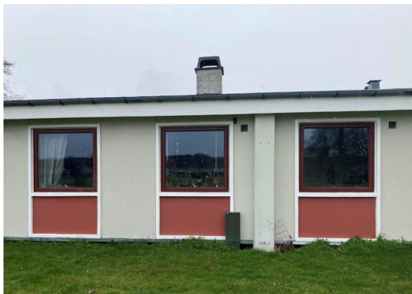
Foto 9.5. Rækkehuse (type A), facade er vedligeholdt.
