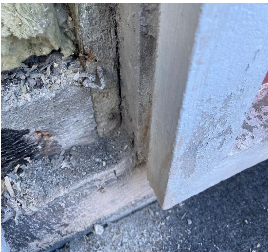
Foto 9.35. Sokkeldetalje ved facade mod betonindfatning. Betonsøjlen står på fundament og betonrem (sort) støder op til søjlen. Betonbrystningen er fastgjort til fronten af betonsøjlen. Smøremembranen er påført front af betonrem samt synlig overside og yderside af fundament. Der er flere steder registreret en trælægge monteret til betonsøjlen. Prøvestedet var tørt og der var ikke tegn på en opstigende fugtpåvirkning af vægkonstruktionen.
