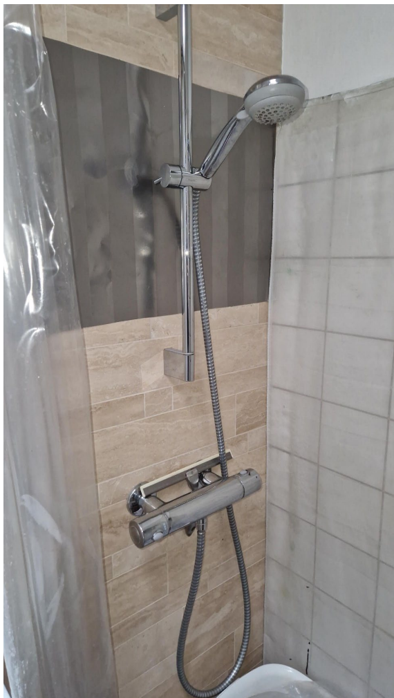
Foto 17.5. Vandinstallationer i bruseniche med skjulte rør.
