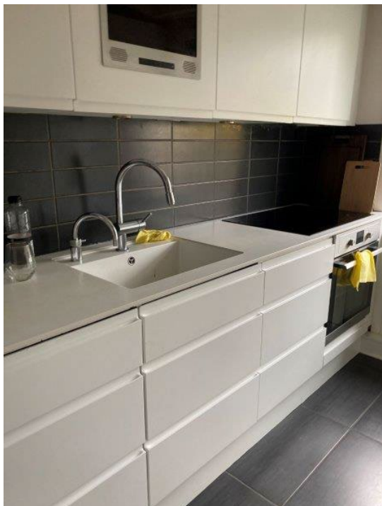
Foto 14.3. Nyere renoveret køkken, højtrykslaminatbordplade, laminat låger, klinker på væg og gulv.
