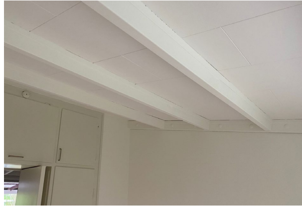
Foto 7.28. Indvendig afstivende trækonstruktion (åse) under betondæk
