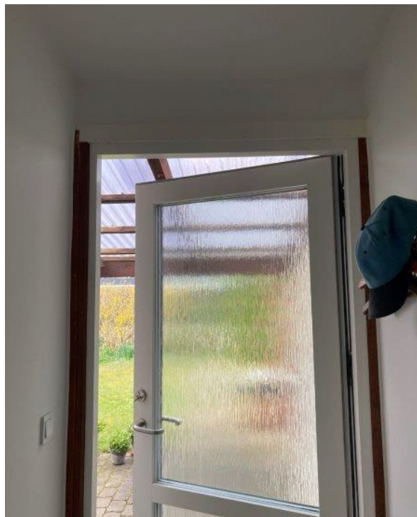
Foto 11.2. Nyere udskiftet hoveddør (indefra)
