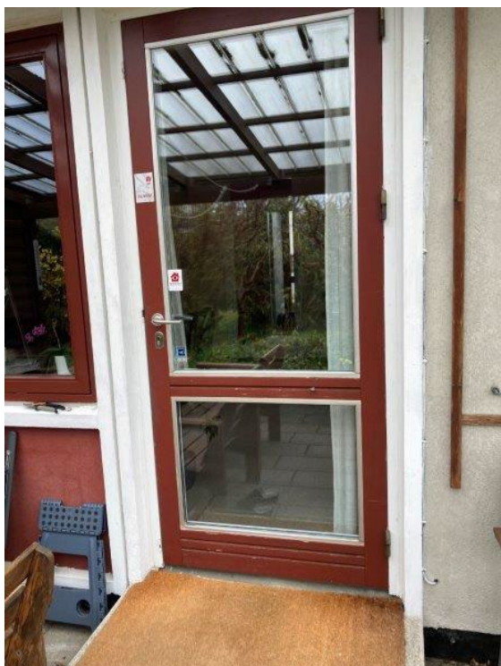
Foto 11.5. Nyere udskiftet træ-havedør med rampe for tilgængelighed (dobbelthus)
