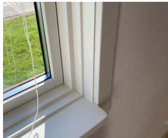
Foto 10.6. Da vinduet er udskiftet er der monteret en ekstra indfatning for tilpasning.
