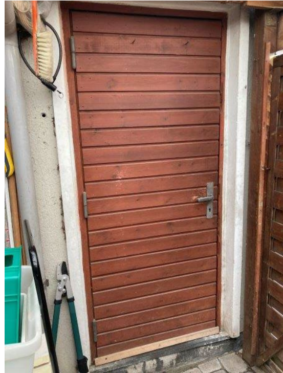
Foto 11.10. Original dør til skur, behandlet med laserende maling.
