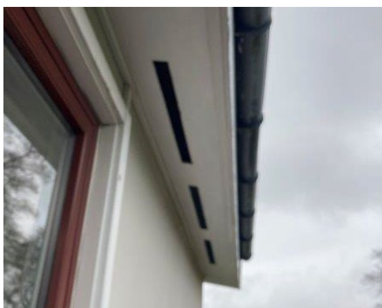
Foto 7.7. Udluftningsspalter (atypisk) i beklædning
