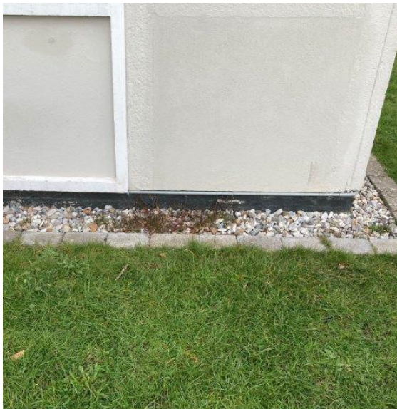
Foto 9.27. Der er etableret drænlag foran facade hvor boligen har været meget skimmelpilaget.
