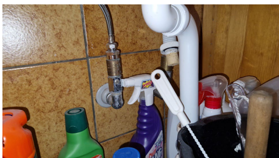
Foto 17.7. Skjulte rør i væggen. Rørene er udført i kobber.
