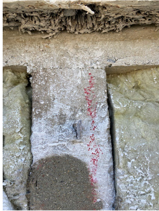
Foto 9.42. Facade Samling betonsøjle og betonbjælke. Vederlaget synes intakt. Der kan registreres en skråtliggende revne umiddelbart under vederlaget.
