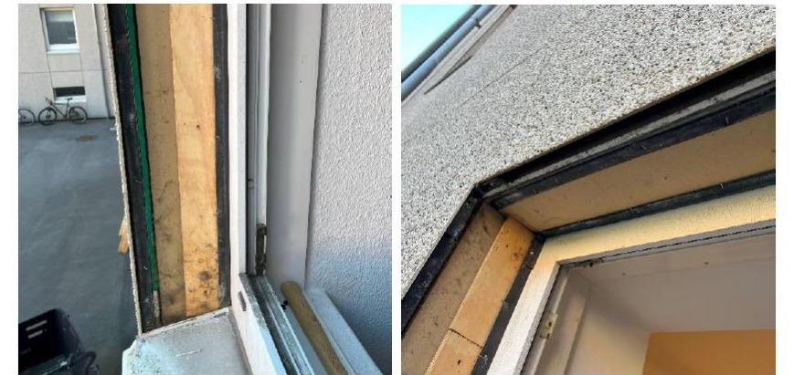
Figur 8, TV: Steni-plade nedtaget i lysning. TH: Steni-plade nedtaget over vindue.
