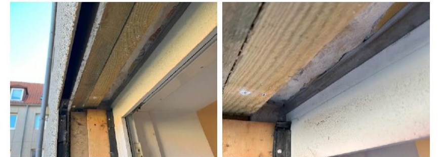
Figur 9, TV: Gipsplade nedtaget over vindue. TH: Elastisk fuge omkring vindue fremstår meget hård.
