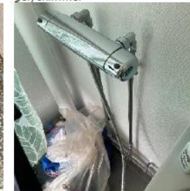
Separat badeværelse, væv på væg, faldstamme og brugsvand i vådzone
